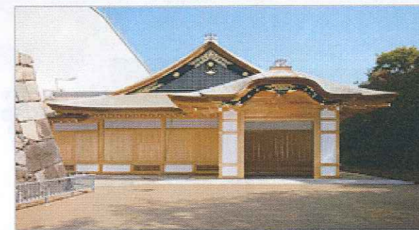
(玄関・車寄 外観)
